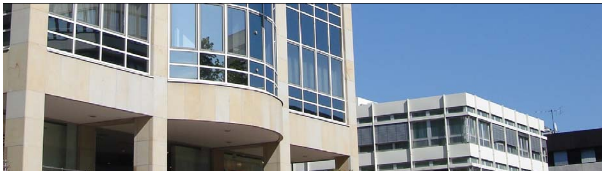
Östliche Karl-Friedrich-Straße 1-5, Pforzheim
