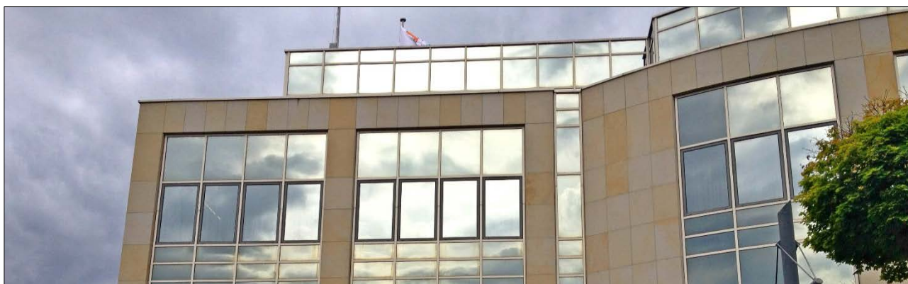
Östliche Karl-Friedrich-Straße 1-5, Pforzheim
